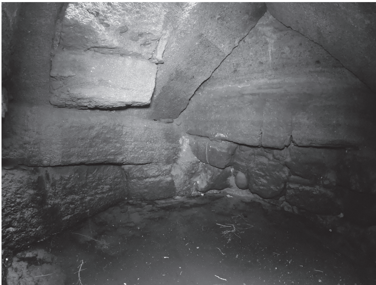
Fig. 6. Nora, saggio PO. Angolo sud-occidentale della camera del pozzo-cisterna (US 21138), vista da nord-est.
