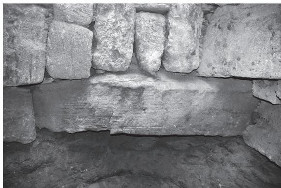
Fig. 4 - Uno dei blocchi del filare di base (I) della cisterna 34000 indicato nel prospetto con la lettera "A". Nella rappresentazione grafica è chiaramente visibile la contrazione delle misure orizzontali subita dal blocco in questione.
